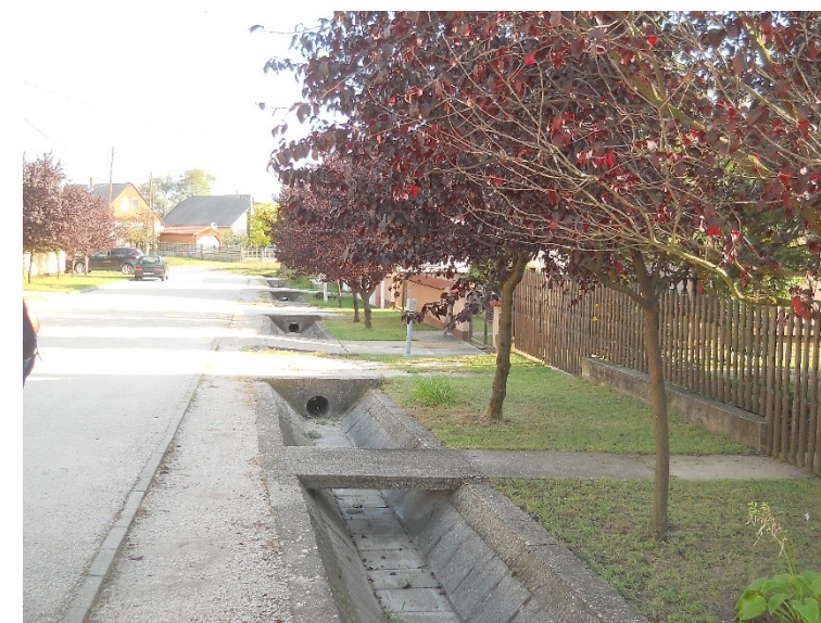
53. fotó: Burkolt vízelvezető árok Keszölcön
