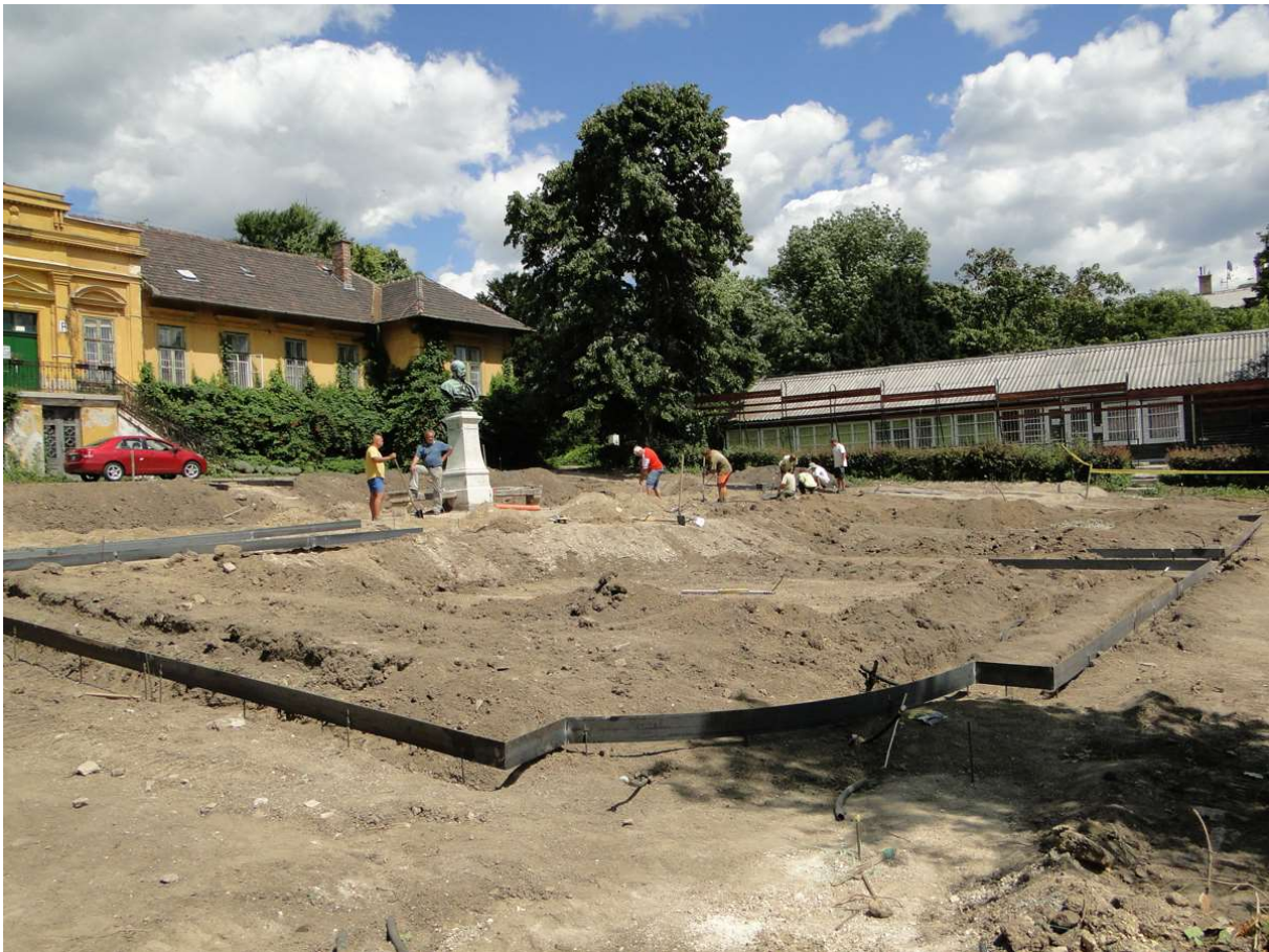
80. A Dísztér felújítása 2011-ben: finom tereprendezés, gypszegélyek behelyezése. A háttérben a pergola felújítás utáni állapota. (Fotó: Honfi Péter)
