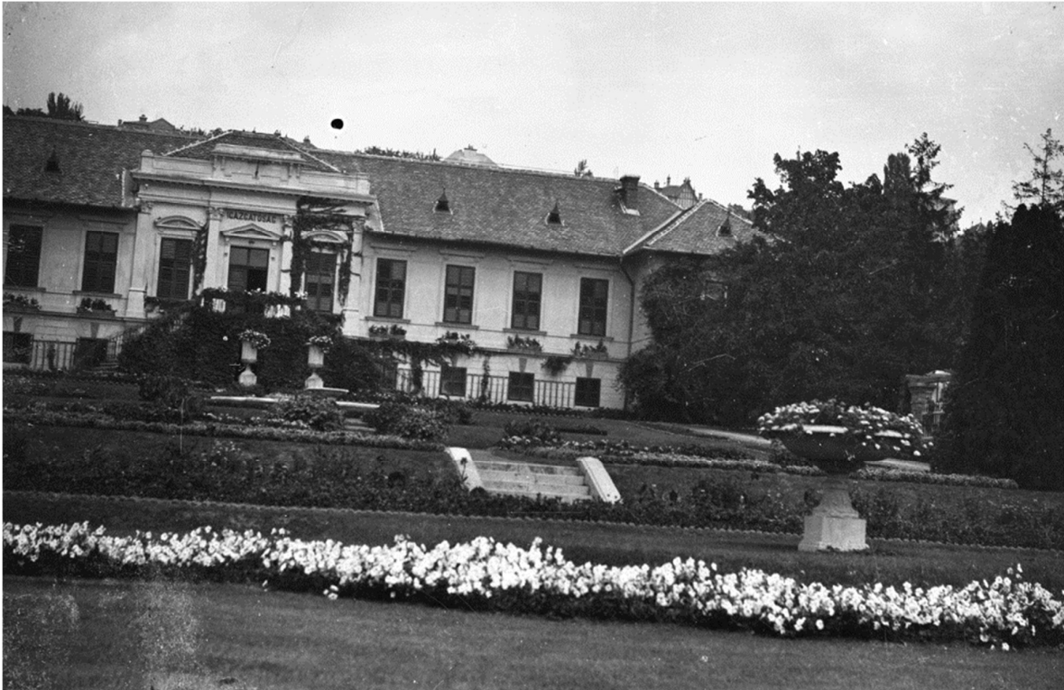
33. A Disztér 1930-ban. A díszmedence megmaradt a Råde időből, azonban a szobor helyett kőtál került a többalakos szobor helyére. Megfigyelhetők a kővázák (3 db) és a tömblépcsőfokú, kő pofafalazatú térközei lépcsőkar. A kép jobb oldalánál még mindig látható a téglafalazatú pergolás kerítés. (Forrás: Fortepan–Zsohár Zsuzsa)
