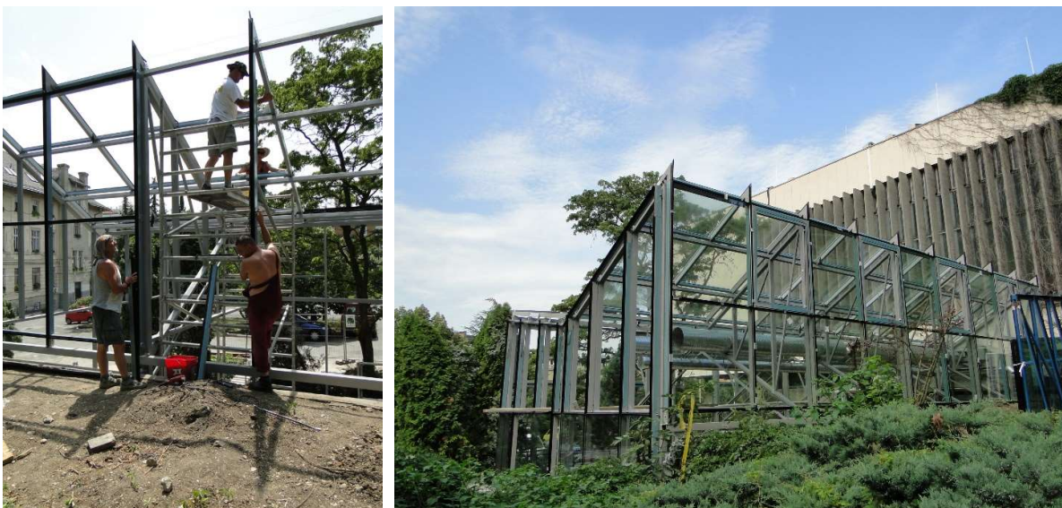
88. A trópusi-szubtrópusi üvegház átalakítása és korszerűsítése 2011-ben: üvegezés (Fotó: Honfi Péter, 2011)
