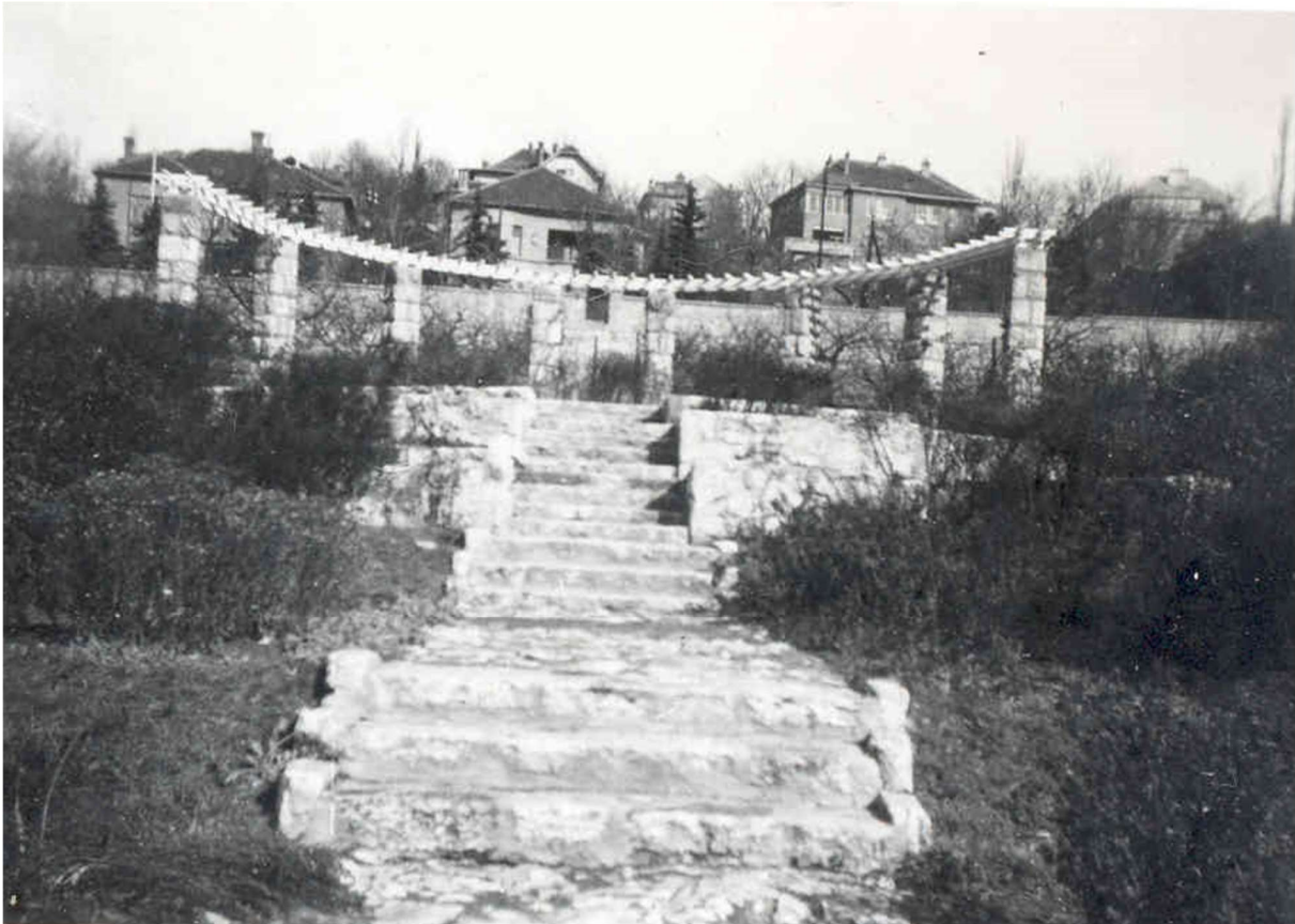
37. Természkő lépcsősor a Felső kert tengelyében és a lépcsősor lezárására szolgáló falazott oszlopú egysoros íves pergola. A pergola mögött gyümölcsfák láthatók. 1933. (Forrás: EFKL fényképtára)
