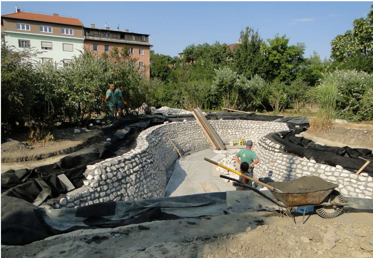
82. A kerti tó felújítása és bővítése 2011-ben: burkolás, mederfalak építése. (Fotó: Honfi Péter)
