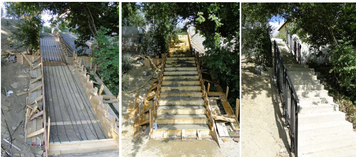
84. A Ménesi úti támfal megerősítő rekonstrukciója 2011-ben: lépcső- és kapufelújítás (Fotó: Honfi Péter, 2011)
