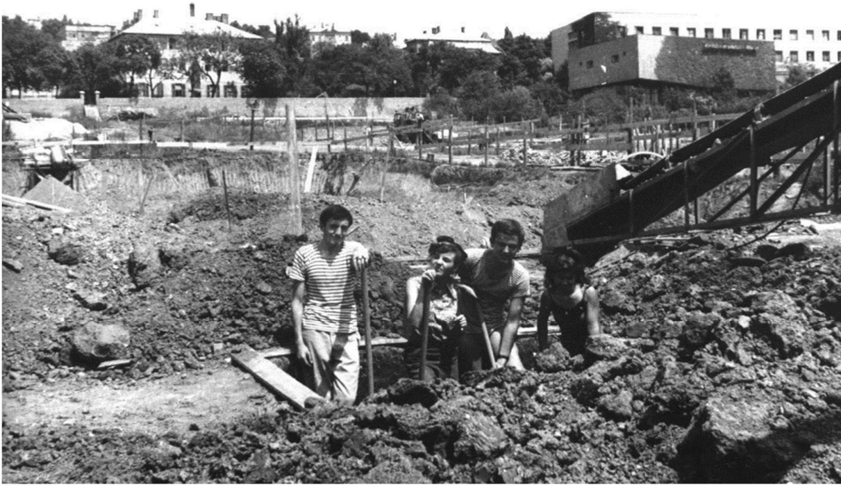
60. Hallgatók dolgoznak az épülő 'K' épület alapozásán. (Forrás: EFKL fényképgyűjtemény, 1969 körül.)
