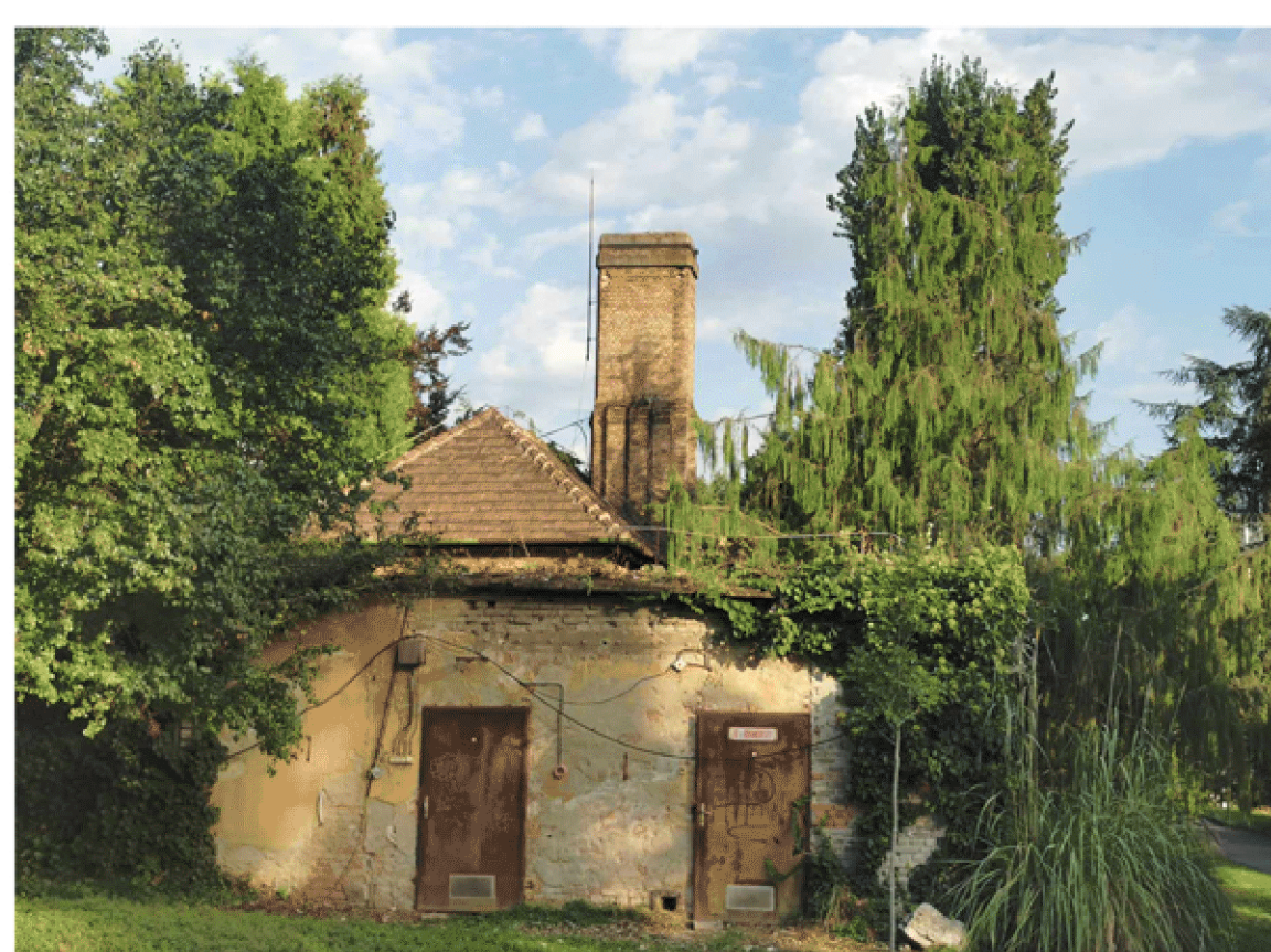
A Kazánház jelenleg romos épülete
